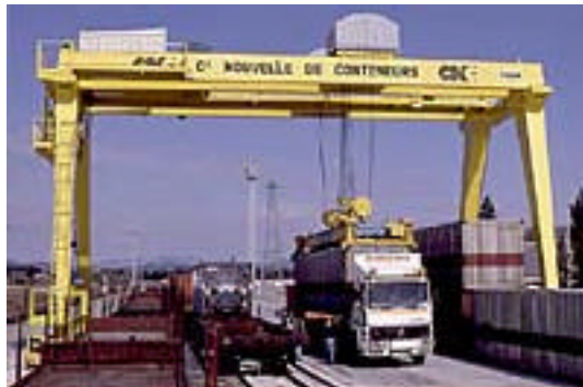
Photo 6 : Aire de desserte routière de ramassage ou de livraison des containers (source SCNF).
